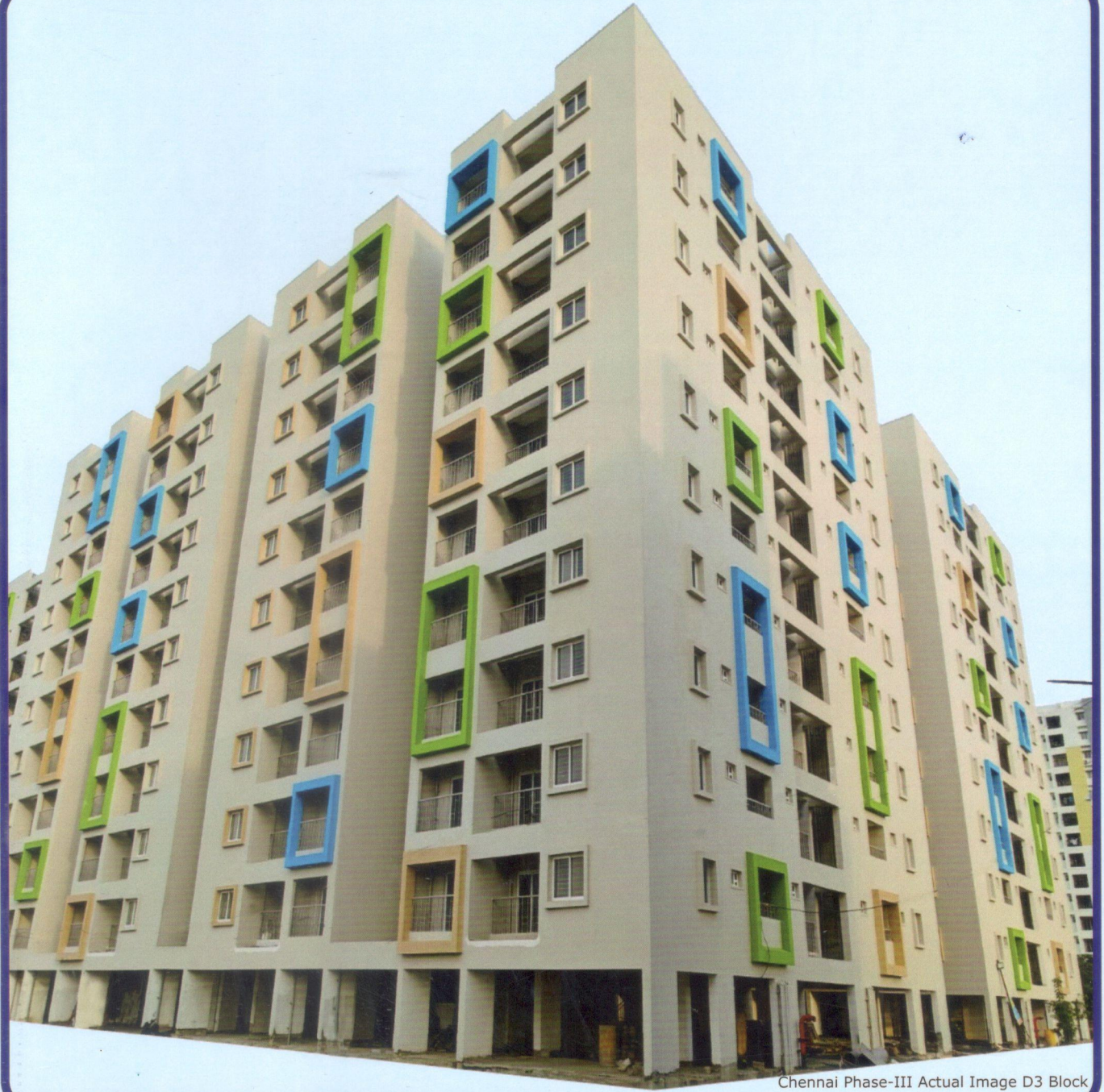
Chennai Phase-III Actual Image D3 Block
