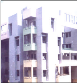
Ahmedabad : 310 DUs Completion Year : October, 2005
