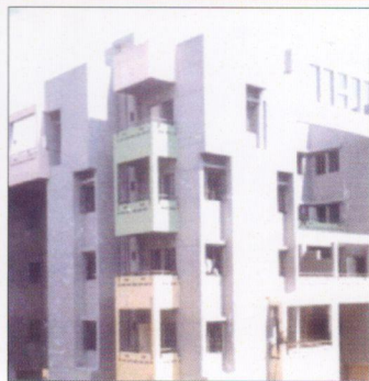
Ahmedabad : 310 DUs Completion Year : October, 2005
